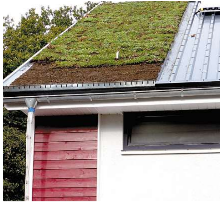
Beispiel eines Hauses mit Gründach.
